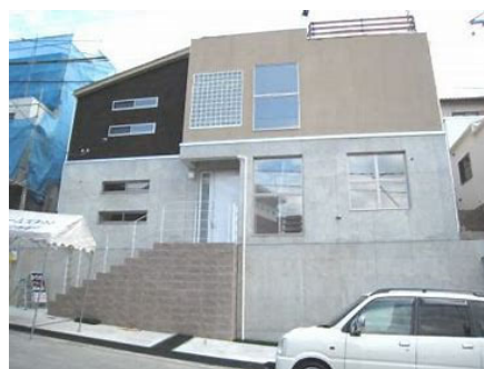
図 6 RC 造に木造を組み上げた立面混構造住宅
