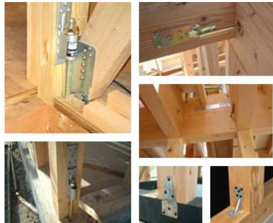
図 4-7 住宅耐震補強用接合金物いろいろ
